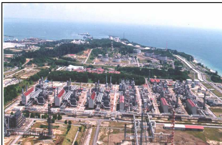
Figure 1: Petronas LNG Complex Site comprises of MLNG Satu, MLNG Dua and MLNG Tiga
