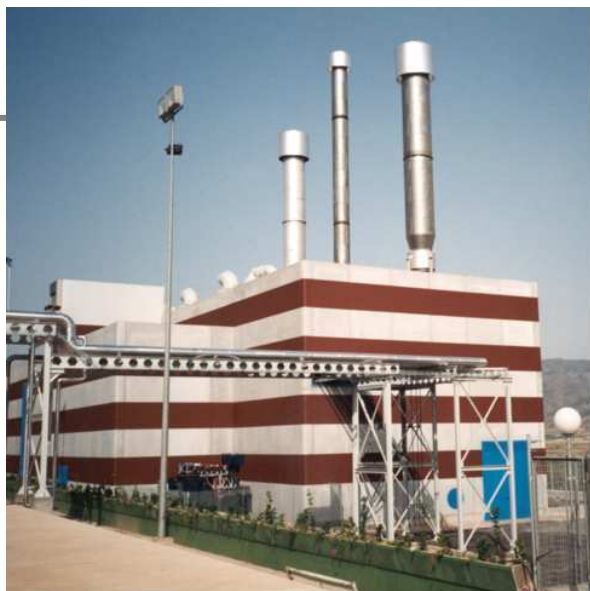
Cogeneración con Motor de Fuel en Fuertes (Comunidad Murciana).
