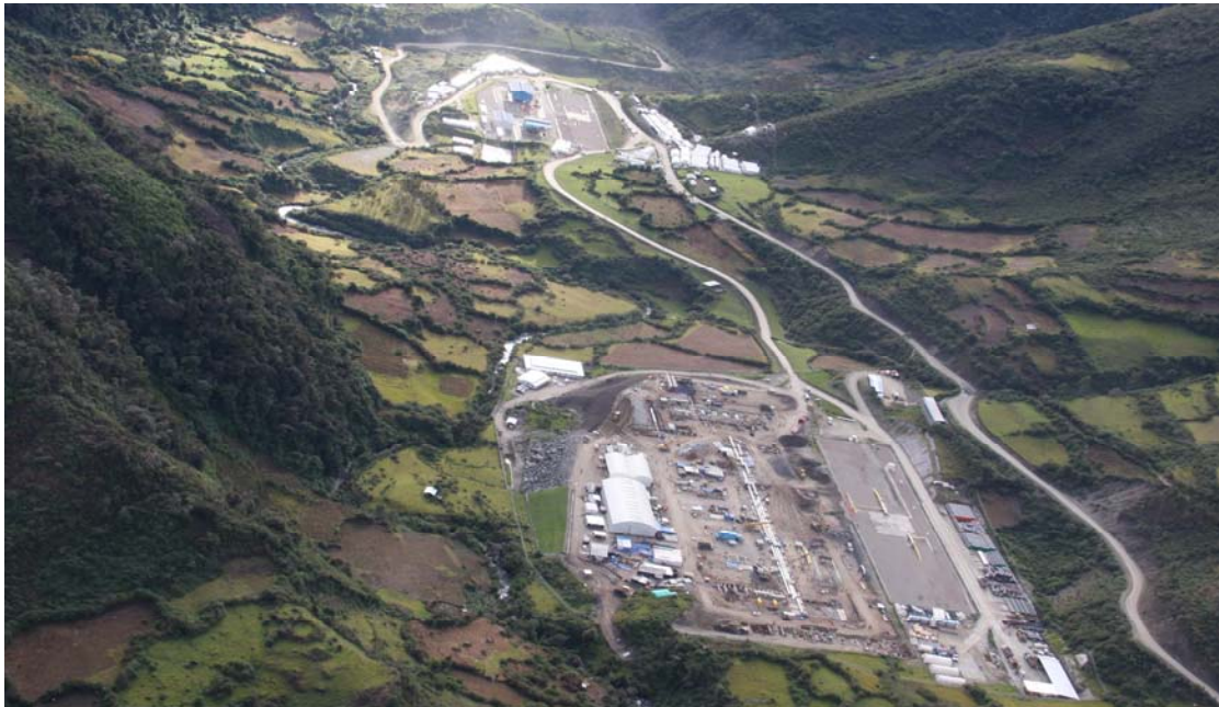
TGP compression installations at PERU LNG pipeline kp 0
