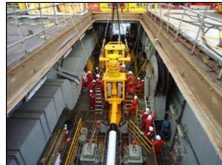
Figure 13. ILS structure positioning
