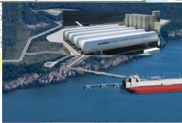
On shore LNG Bunkering Station
