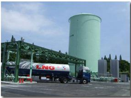
Figure 2.7 LNG satellite terminal
