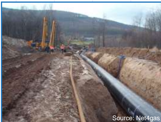
Construction of „Gazelle“
