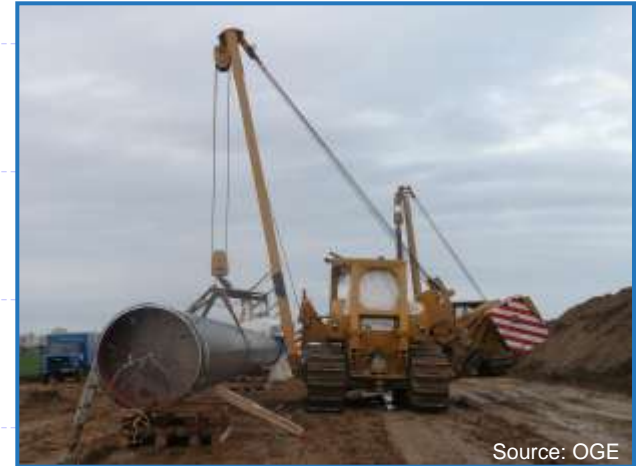
Construction of NEL pipeline
