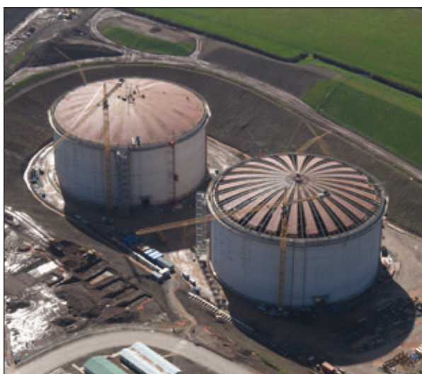
Construction of the Dragon LNG terminal.
