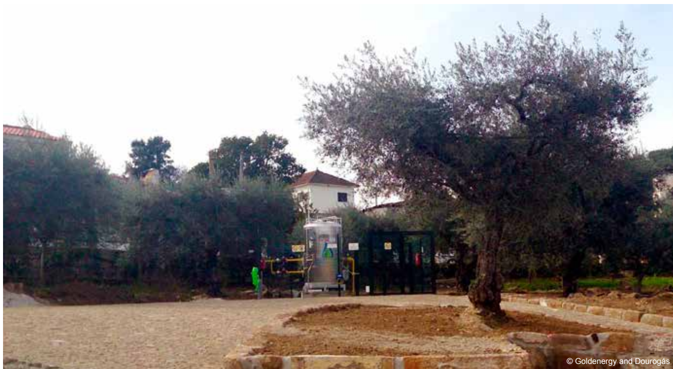
Goldenergy micro LNG satellite plant for LNG retail in Portugal
