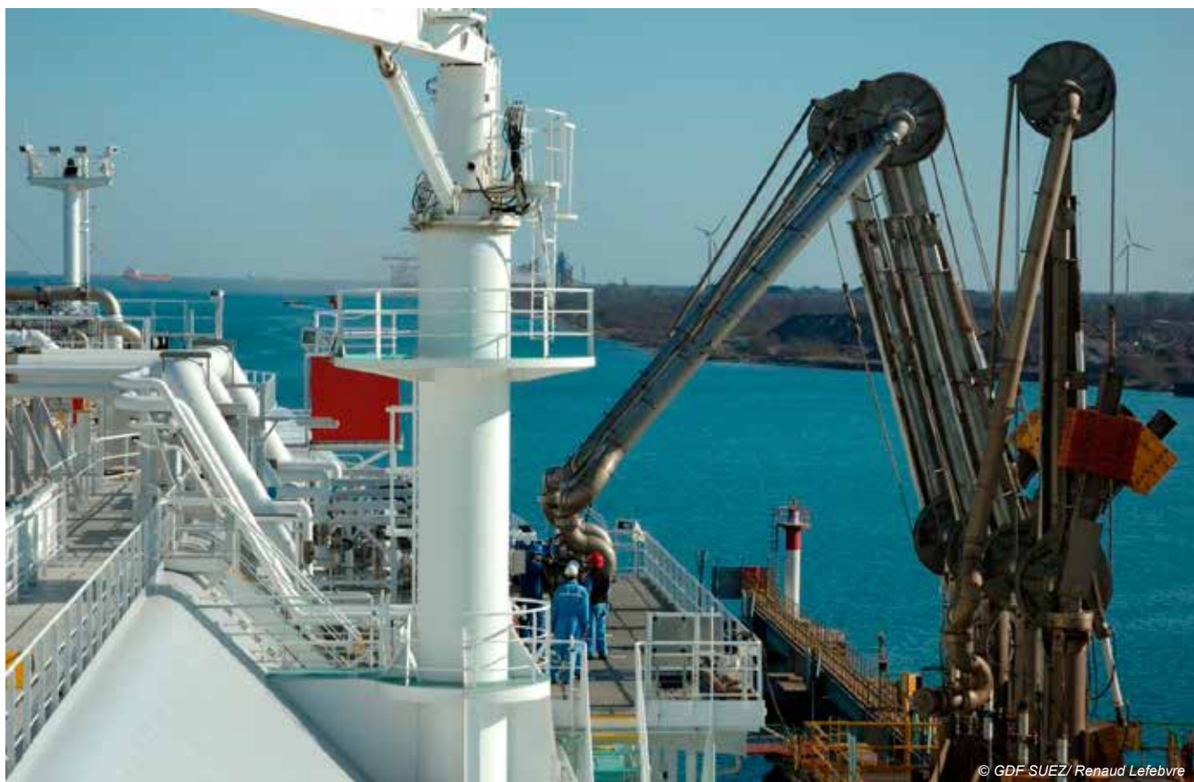
GDF SUEZ Global Energy LNG tanker
